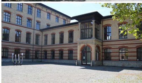
Oben: CAB Kiesplatz links Rampe Unten: CAB Kiesplatz rechts
